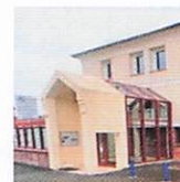
35 rue du Maréchal Leclerc (locaux de l'UDAF DE L'Oise à BEAUVAIS)
